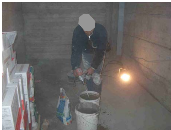
Preparazione dell'impasto: miscelazione con attrezzo ad elica applicato a trapano
