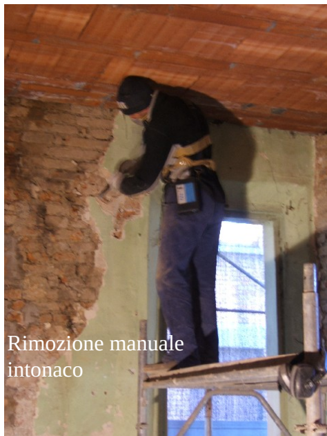
Demolizione manuale inframezzo
